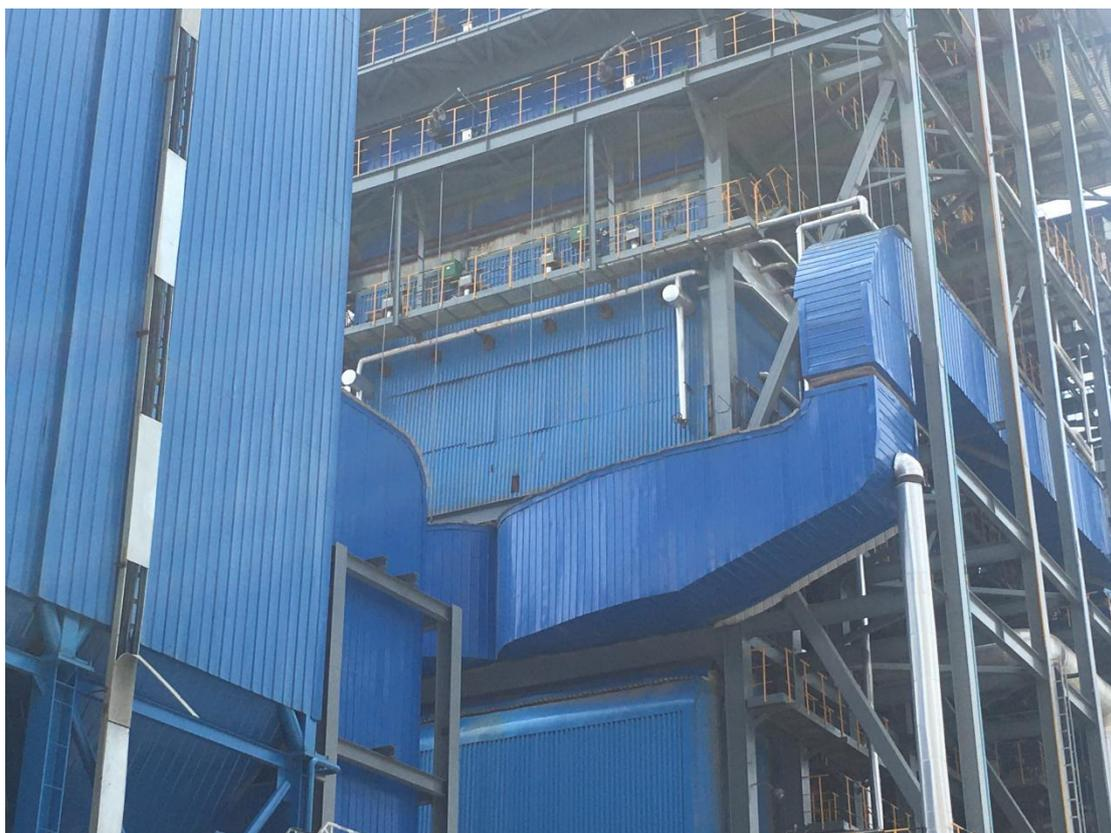
9#锅炉低氮燃烧 SCR 脱硝
